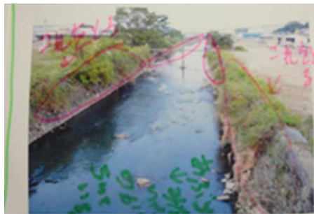
図 3-3-8 (児童撮影) 徳島市国府町と石井町の境付近にある石積み護岸加減堰 この加減堰の前後の川幅は 24m あるが、この堰は 100m にわたり川幅を 17m に狭めている。石井町の下流域の徳島市が浸水被害を受けないようにすることを目的に 1932 年(昭和 7 年)に造られた。
