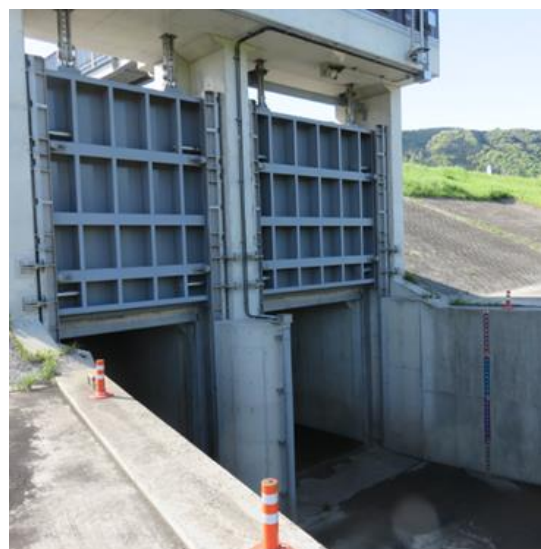
図 3-5-10 吉野川出水時に桑村川に 吉野川の水が逆流するのを防ぐ水門
