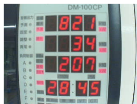
図1 デマンド監視装置の表示 (9時撮影)
