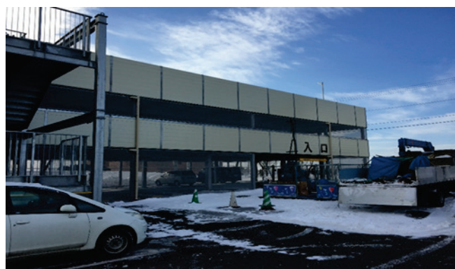
図9 建設中の立体駐車場
