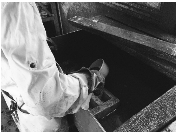
写真4 型枠に油付けをしている様子
